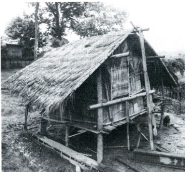
棟持ち柱のある高床式穀倉（鳥越憲三郎編『雲南からの道—日本人のルーツを探る』講談社、昭和58年4月25日、130頁）
